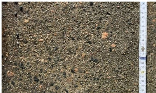
Grøn Bro Betontype: AR (2002)
