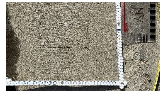
Grøn Bro Betontype: Ny beton (2010)
